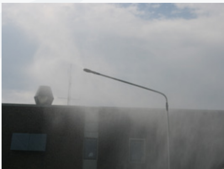
Roterende sløkkespyd som raskt dekker brennende overflater med vanddamp og vanddråper som kveler og kjøler brannen.
